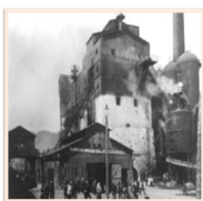
1894 г. Пуск доменной печи
